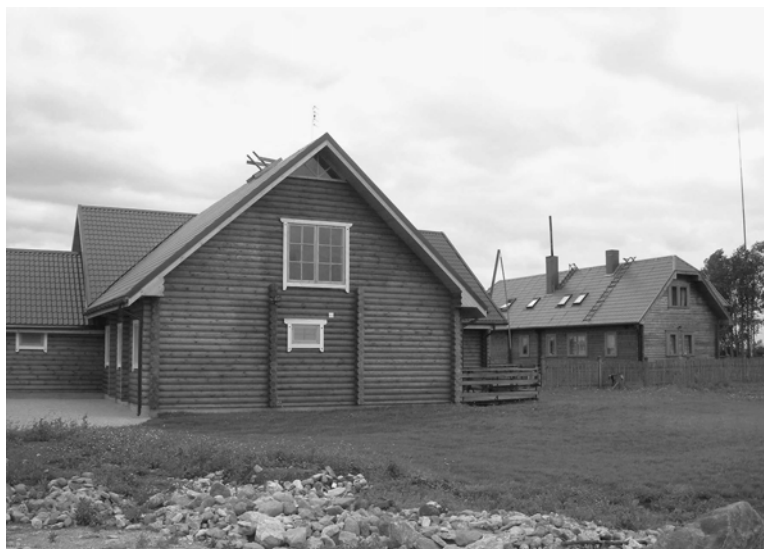
Naujieji Auksučių Jurgio Gudaičio ūkio centro pastatai
